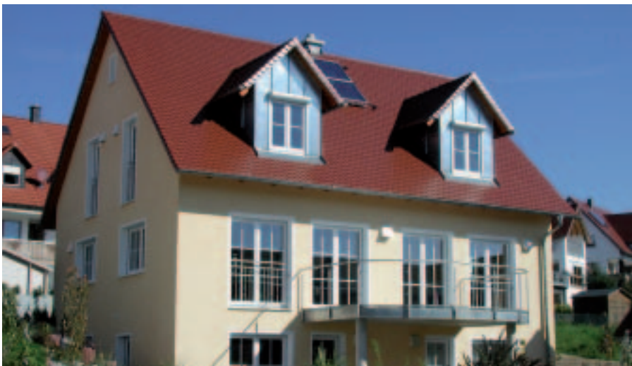
Mit 24 cm KS protect® abgeschirmt gegen Mobilfunkstrahlung: Wohnhaus in Wemding
